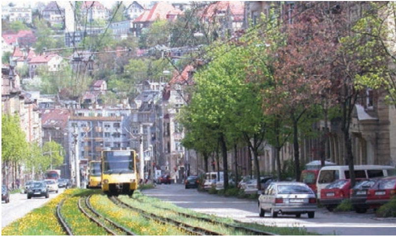
Abbildung 11.6: Rasenbahnkörper der Stadtbahn in Stuttgart (Quelle: AUS 2010)
