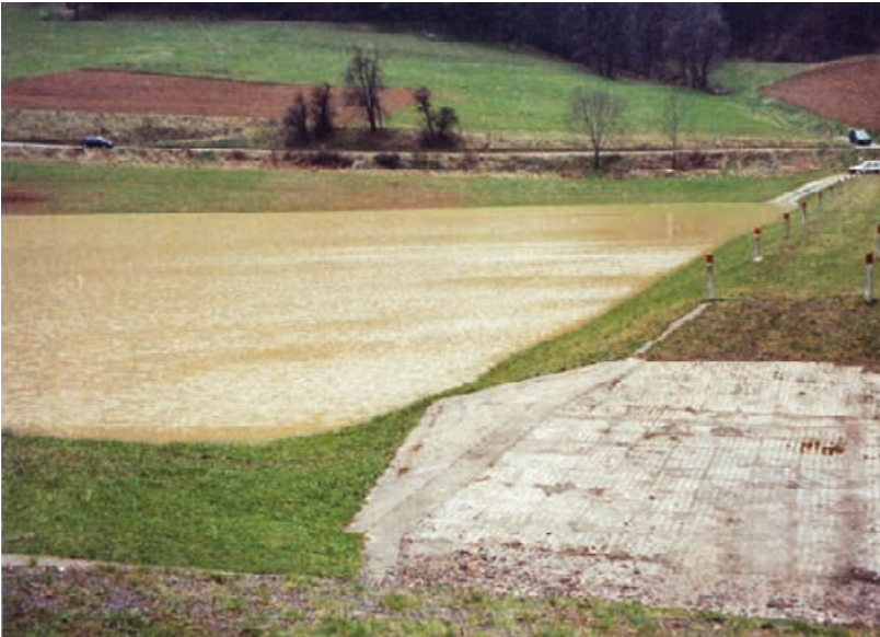
Hochwasserschutz durch Rückhaltebecken bei Ammerbach nach einem Starkregenereignis im April 1994 (Quelle: Stadt Jena)
